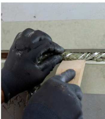
Vložte povrazec Nullifire FJ203 do škáry.
