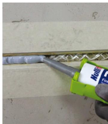
Škáru môžete podľa potreby utiesniť pomocou Nullifire FS702, FS703 alebo illbruck SP525.
